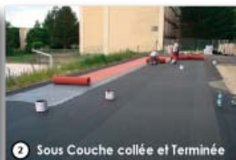
3 Début Installation Couche d'Usure
