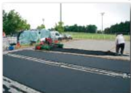
Une première en France, Sous Couche Coulée de 20 mm sur finition gravillonneuse. (Terrain de Rugby Colomiers)
