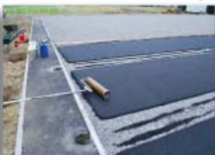
Une première en France, Sous Couche Coulée de 20 mm sur finition gravillonneuse. (Terrain de Rugby Colomiers)
