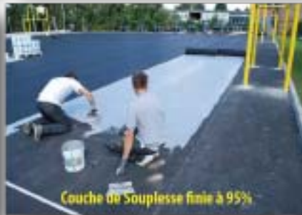
Couche de Souplesse finie + Couche d'Usure EPDM 4 mm
