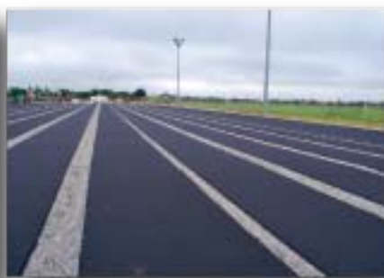
Une première en France, Sous Couche Coulée de 20 mm sur finition gravillonneuse. (Terrain de Rugby Colomiers)
