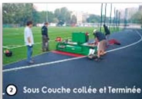
2 Application du Bouche Pores
